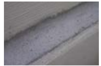
Ausgerundete Hohlkehle aus KÖSTER Sperrmörtel WU
