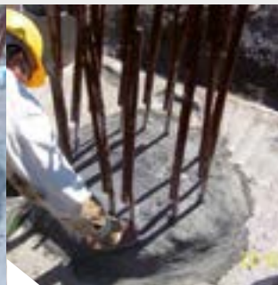
Abdichtung des Pfahlkopfes mit KÖSTER NB 1 grau
