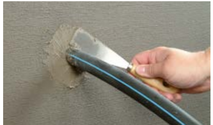
Um die Abdichtung zu schützen, wird die Fläche mit KÖSTER KB-Fix 5 verspachtelt.
