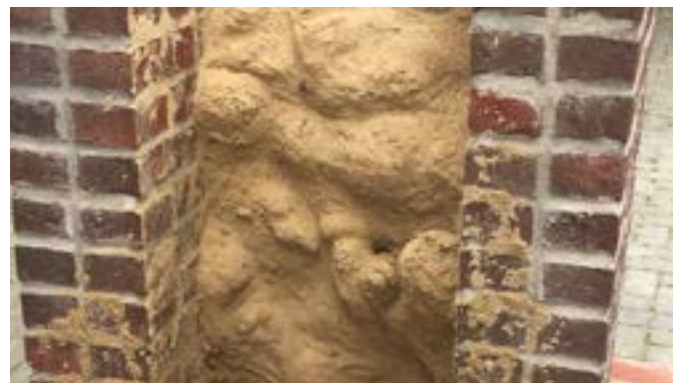
Schleierinjektion (rückseitige Ansicht)
