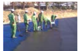
Abdichtung mit KÖSTER Deuxan 2K-Spachteldicht
