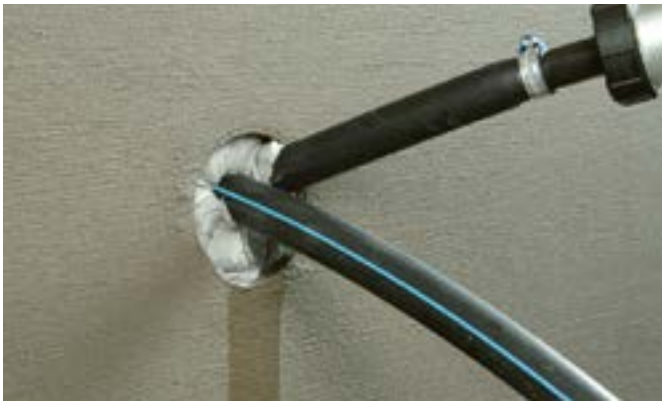
KÖSTER KB-Flex 200 wird mit der KÖSTER Handpistole in den Zwischenraum gepresst.
