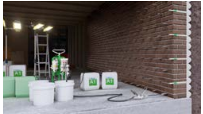
Mauerwerk Schleierinjektion
