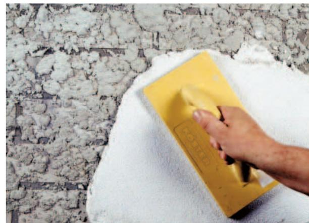
Abb. 2: Sanierputz-Auftrag auf Spritzbewurf zur klassischen Abdichtung gegen aufsteigende Feuchte
