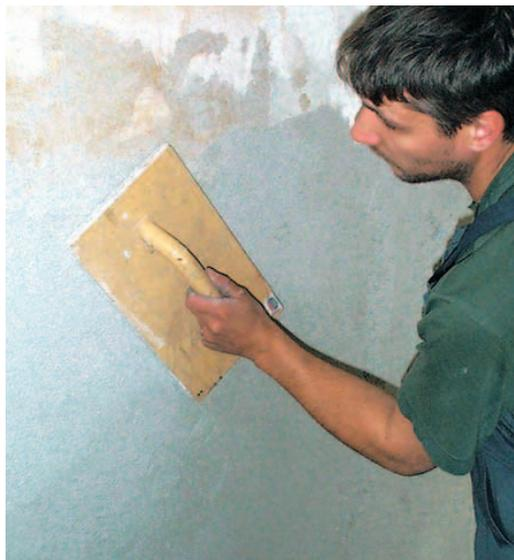
**Abb. 4:** Nach ausreichendem Anziehen wird abgerieben und geglättet
