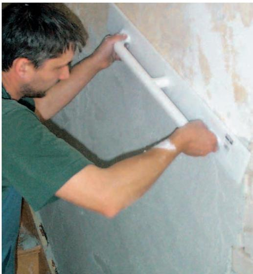
**Abb. 3:** Nach dem Aufziehen das Abziehen des Sanierputzes mit einer Kardätsche
